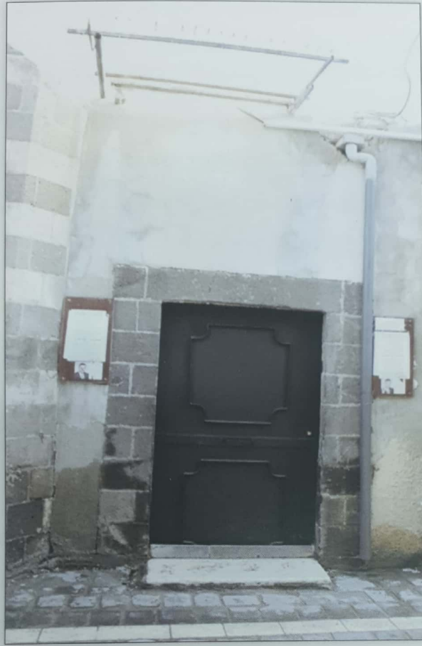
الشكل - ١١٢ مسجد المرادي مدخل مسجد المرادي الموجود في الواجهة الغربية
