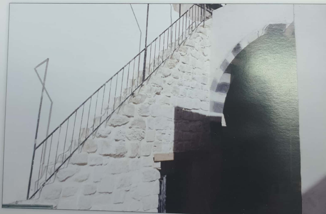
الشكل - ١٢٩ مسجد بندق الدرج المؤدي للسطح بعد ترميمه
