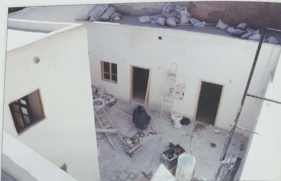
الشكل - ١٢٨ جامع بندق ترميم الواجهات الداخلية لصحن المسجد
