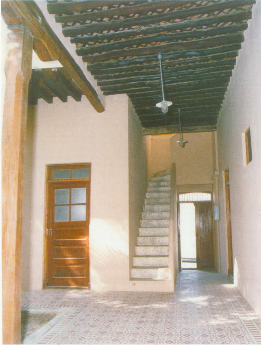
سقف الليوان بعد الترميم، وهو كما يعرف من «الجنديل» أو خشب الصاج والخصوص.
