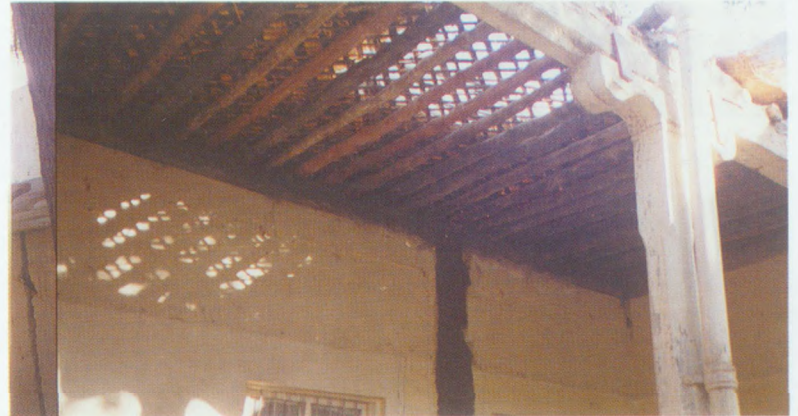
سقف الليوان قبل الترميم.
