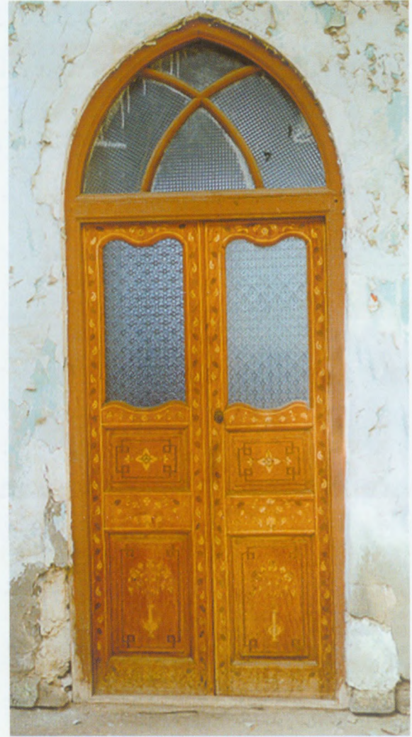
نماذج لأبواب وخزائن بيت المرزوق (بيت السدو) الخشبية المميزة بنقوشها ودقة صنعها بأيدي حرفيين كويتيين.
