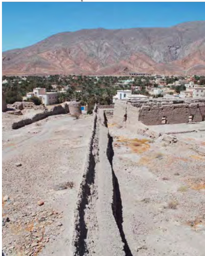
الشكل ٢ - ٢٥: حارة اليمن، الجدار الجنوبي.
