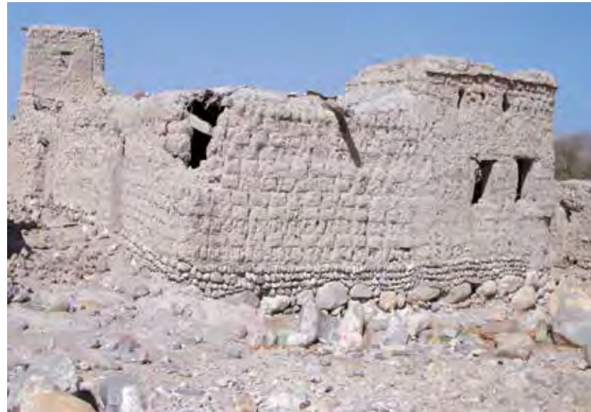
الشكل ٣ - ٣٠: مسكن تقليدي ذو أساسات حجرية.
