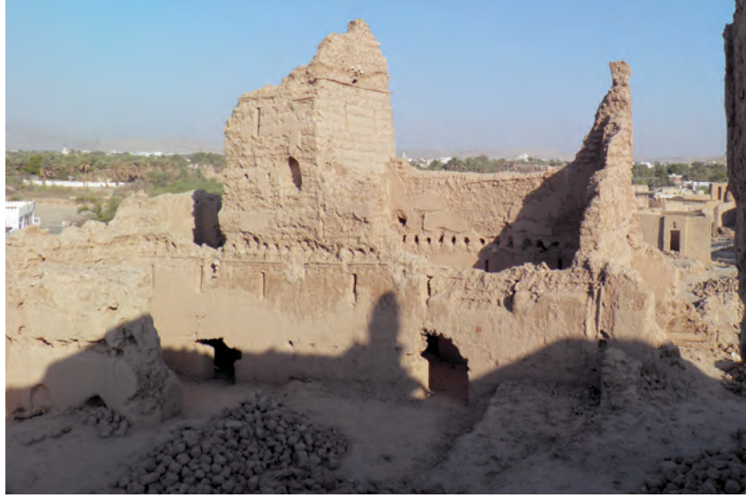
الشكل ٤-٤: السليف، التآكل والتدهور الذي يعاني منه البناء.
