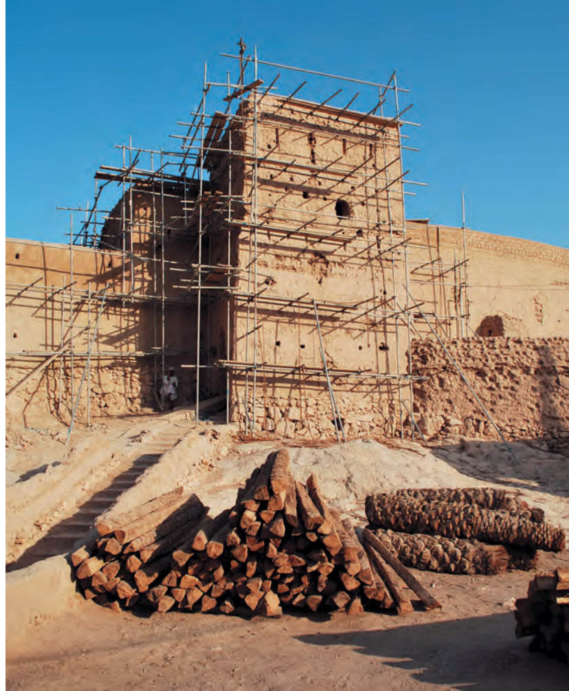
الشكل ٢-٨: حارة السليف، ترميم البرج (A2).
