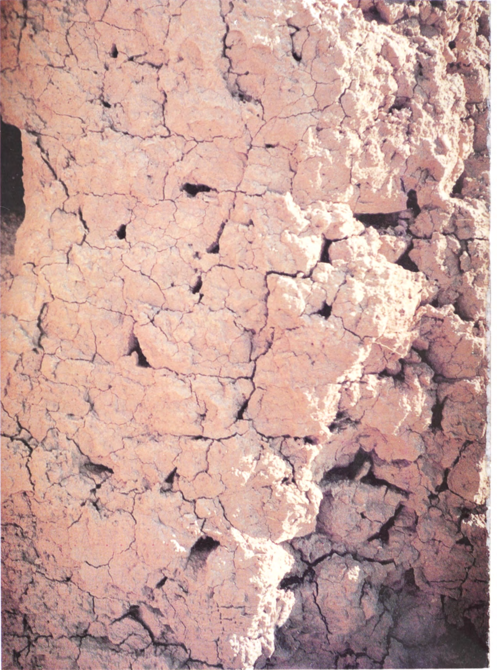
(شكل ٤) جدار مبني بالطابوق اللبن - قلعة أركيات بقطر.
