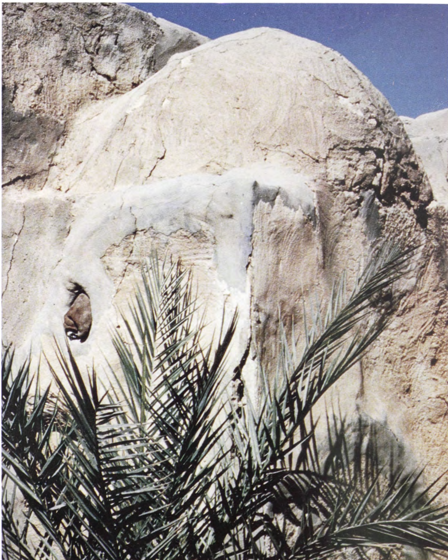
(شكل ٦٥) حمام ذو سقف على هيئة قبة نصف دائرية ملحق بغرفة بيت تقليدي قطري - الخور .
